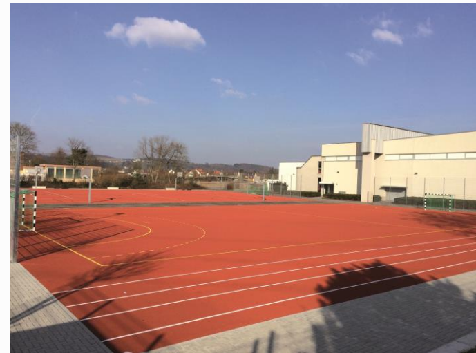
Außensportgelände vor der Untermainhalle
